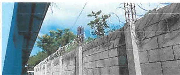
Foto 1: Instalación de alambre rizador.
