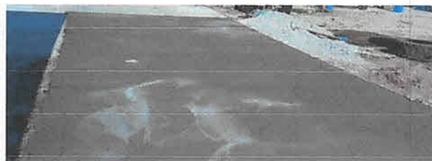
Foto 2: Elaboración de torta de concreto 8cm de espesor.
