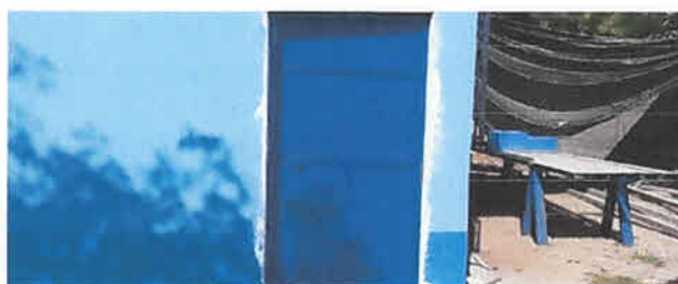
Foto 3: Instalación de puerta de metal medida de 1*2mts.
