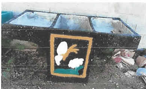
Foto 5: Instalación de pila con dos lavaderos.
